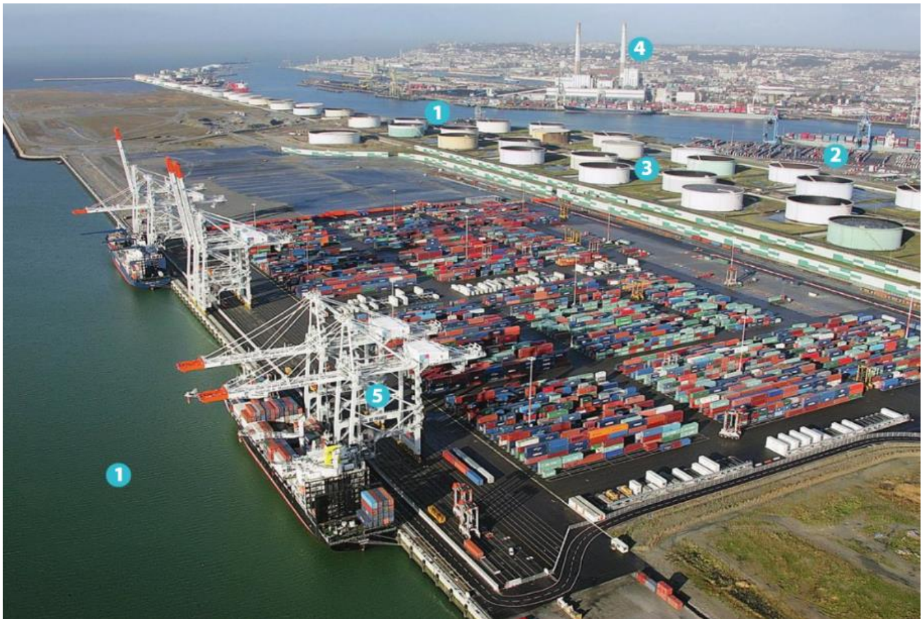
① Bassin en eaux profondes de 15 m de profondeur ② terminaux à conteneurs ③ terminal pétrolier ④ centrale électrique ⑤ portiques électriques géants permettant de décharger 2 conteneurs simultanément.
